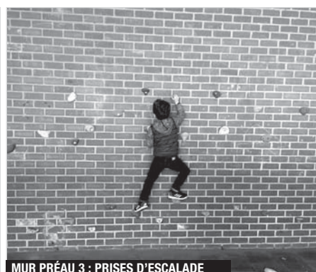
MUR PRÉAU 3 : PRISES D'ESCALADE
